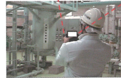
拡張現実感技術を活用した プラント解体支援システム
