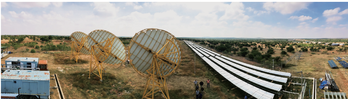
IISc の Challakere Campus に設置されているディッシュ式(左)およびトラフ式(右)太陽熱発電装置
