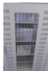
36kW 級試験電池
