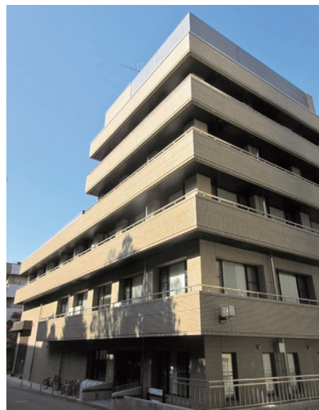
改修工事が終わった先端エネルギー科学実験棟
