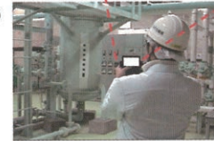
拡張現実感技術を活用した プラント解体支援システム
